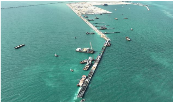
รูปที่ 2-3 งานก่อสร้างเขื่อนกันคลื่น
