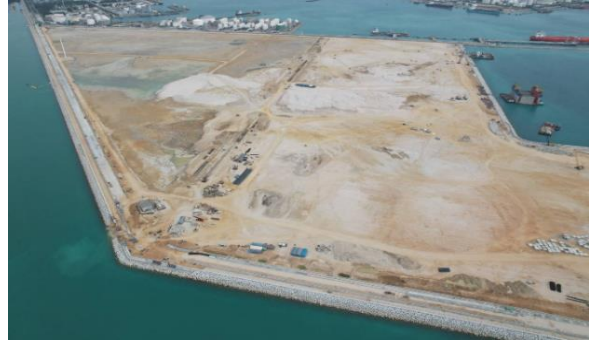
รูปที่ 2-2 งานก่อสร้างเขื่อนกันทราย
