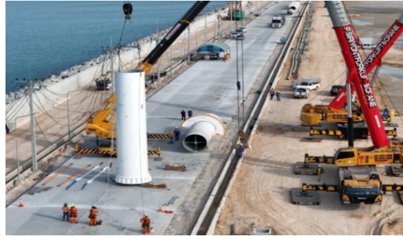
รูปที่ 2-7 งานติดตั้งเครื่องหมายเดินเรือ
