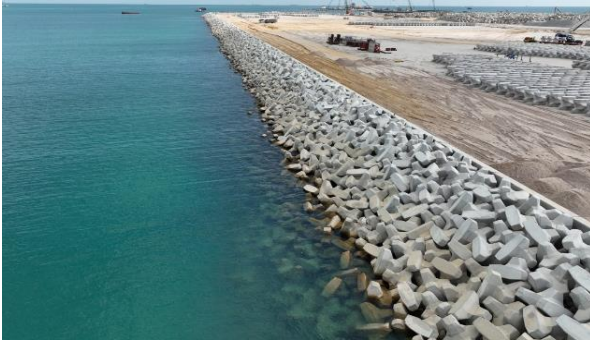
รูปที่ 2-2 งานก่อสร้างเขื่อนกันทราย
