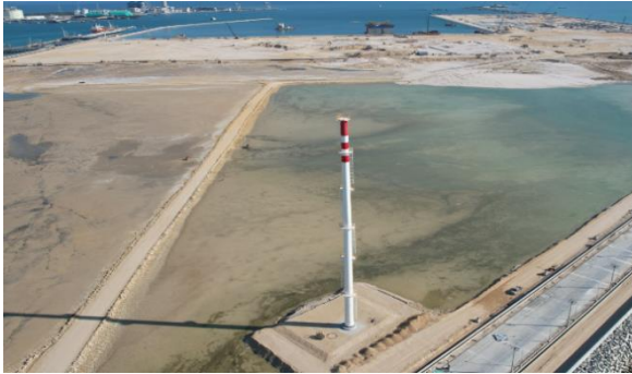
รูปที่ 2-7 งานติดตั้งเครื่องหมายเดินเรือ
