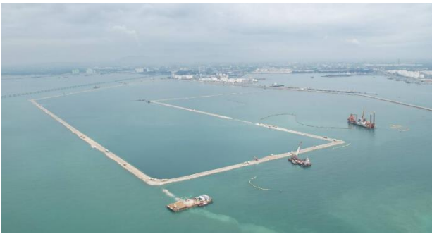
รูปที่ 2-2 งานก่อสร้างเขื่อนกันทราย
