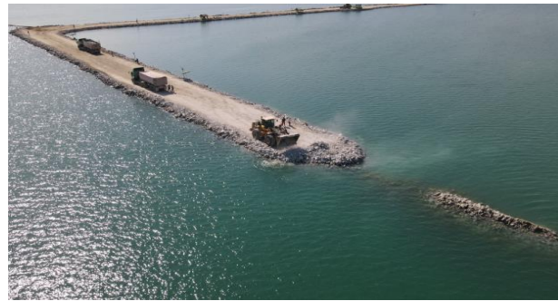
รูปที่ 2-2 งานก่อสร้างเขื่อนกันทราย
