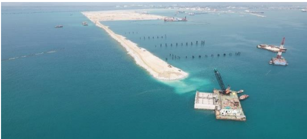
รูปที่ 2-3 งานก่อสร้างเขื่อนกันคลื่น
