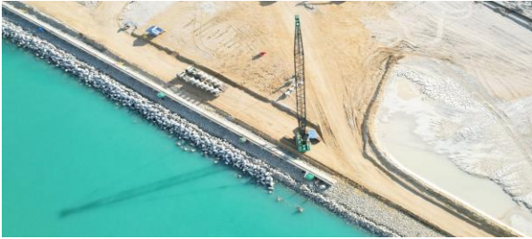
รูปที่ 2-2 งานก่อสร้างเขื่อนกันทราย
