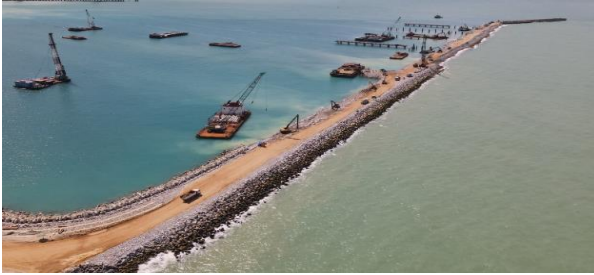
รูปที่ 2-4 งานก่อสร้างเขื่อนกันคลื่น
