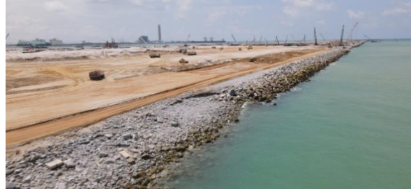
รูปที่ 2-3 งานก่อสร้างเขื่อนกันทราย
