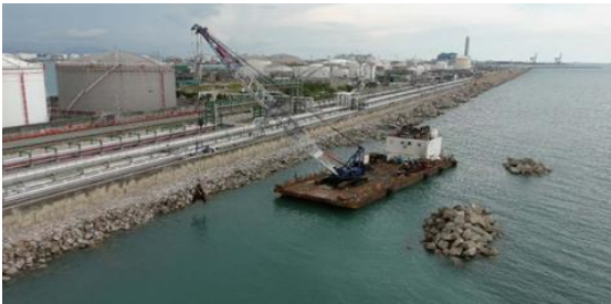
รูปที่ 2-3 งานแก้ไขเขื่อนกันทรายเดิม
