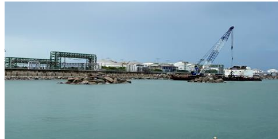
รูปที่ 2-3 งานแก้ไขเขื่อนกันทรายเดิม
