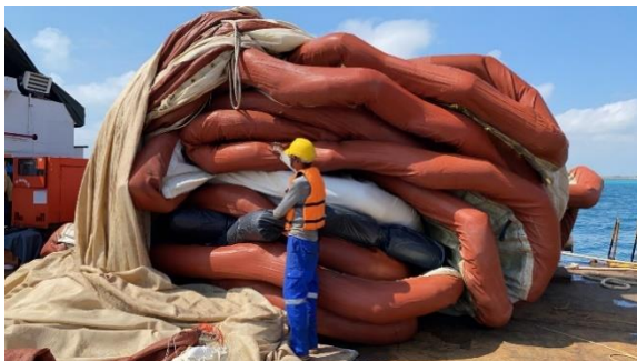
รูปที่ 3-2 การซ่อมแซมม่านกันตะกอนและการจัดทีมงานเฝ้าระวังและสำรวจป้องกันม่านกันตะกอน
