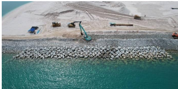
รูปที่ 2-2 งานก่อสร้างเขื่อนกันทราย
