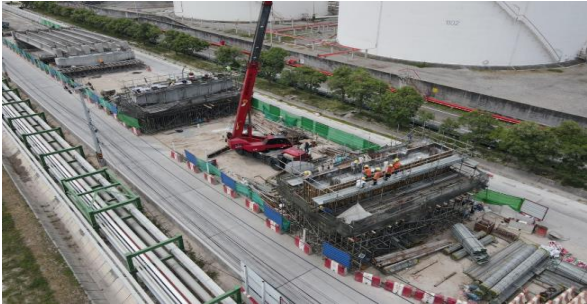
รูปที่ 2-6 งานก่อสร้างสะพานทางเข้า-ออกโครงการ
